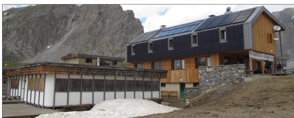
Dans les années 1970, un bâtiment particulier était monté au col (au premier plan). Les spécialistes de l'architecture criaient au génie, d'autres sont restés plus dubitatifs. La structure a été démontée.
